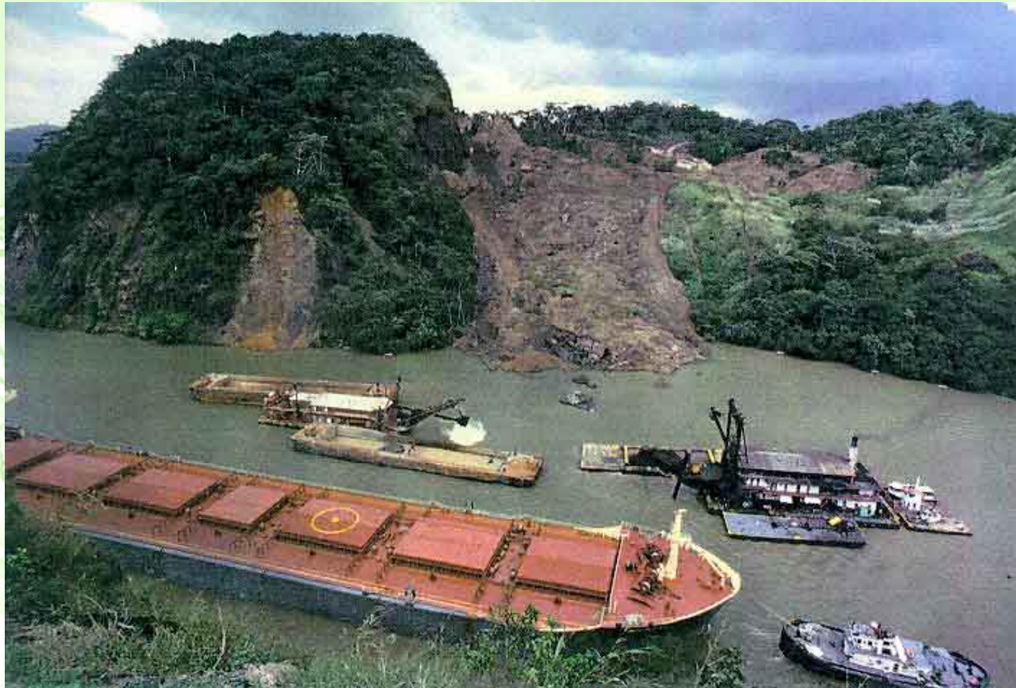
Работы по очистке русла канала от оползня
